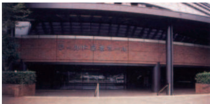
正面玄関 Main entrance
